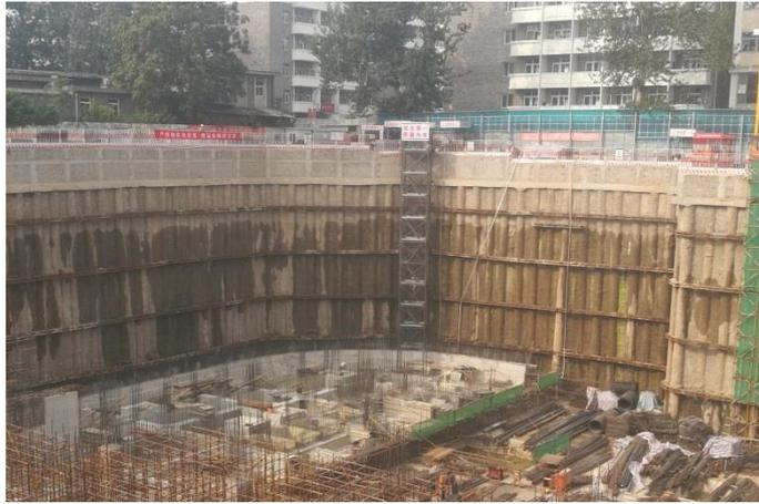
图 5 餐饮综合楼工程西南区基础上翻梁施工
