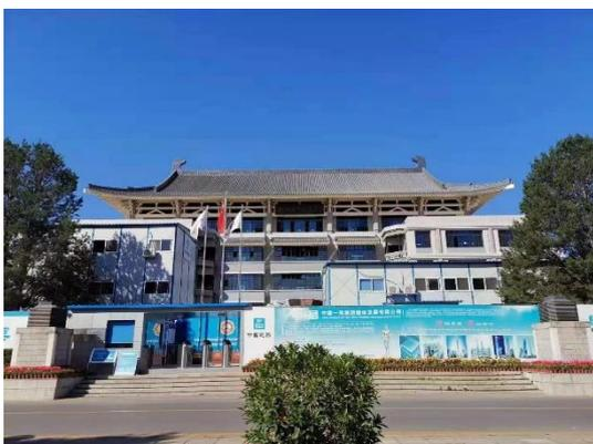
2.太平洋大厦外立面改造：四个立面基本完成陶板施工，南、北、西立面吊篮已经拆除，正在进行东立面收口施工。
