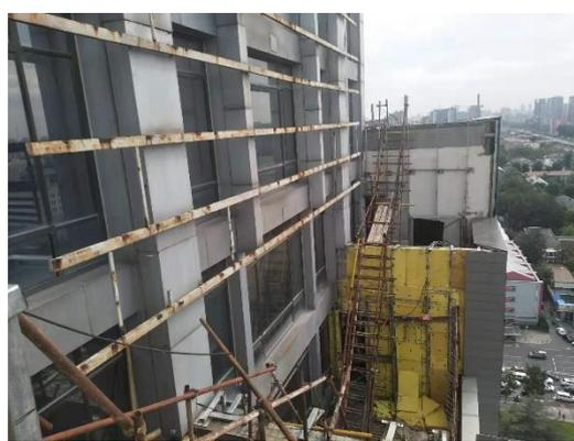
图 10 图书馆东楼修缮改造外脚手架拆除
