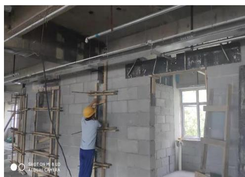
图5 城环景观设计学大楼二次结构施工
