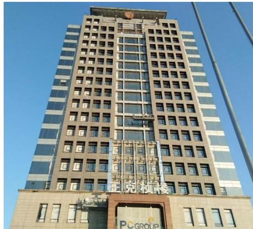
图 13 太平洋大厦南立面陶板面层完成，中间位置正在做岩棉保温层
