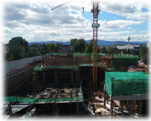
图7 国家发展研究院结构施工
