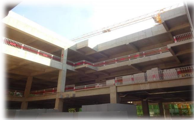
图9 餐饮综合楼工程结构施工完成
