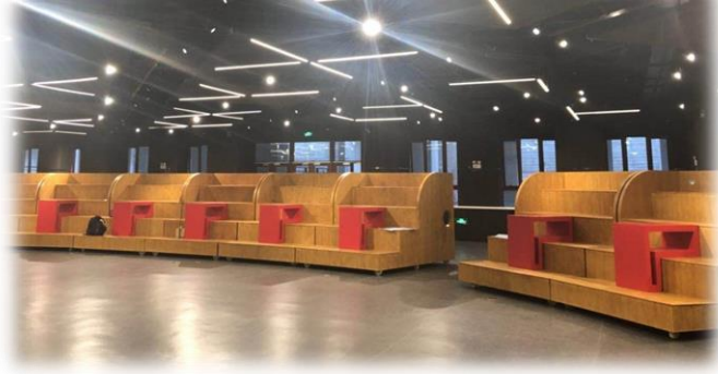
图 3 新太阳 91 剧场装修工程
