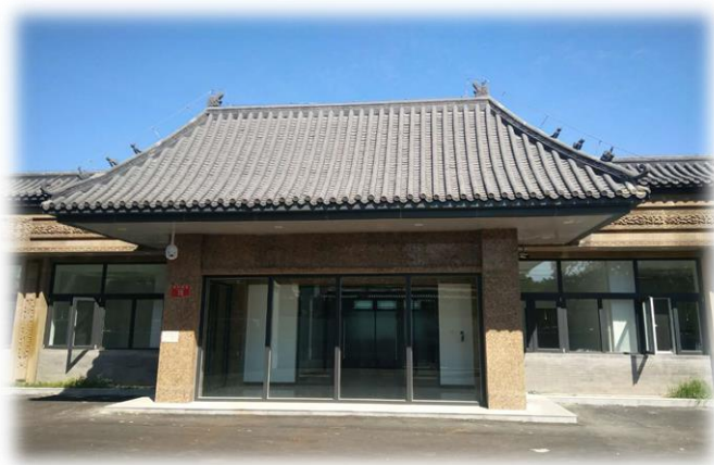
图 1 继续教育学院达园宾馆装修改造工程
