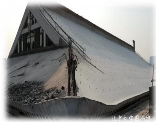
图 14 图书馆东馆修缮改造工程主楼斜屋面东侧找平层及西侧防水施工
