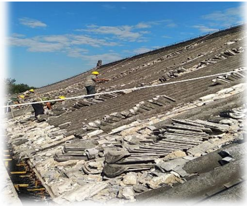
图 12 外文楼及民主楼修缮工程屋面施工
