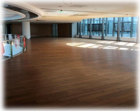
图 10 生命科学科研大楼木地板施工
