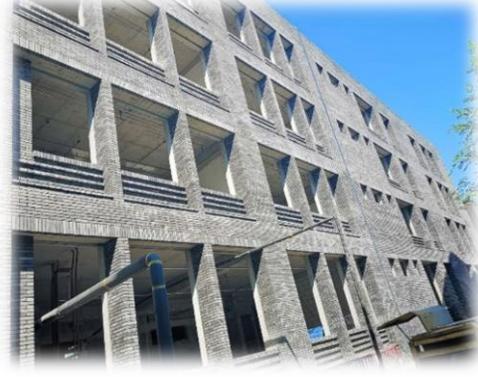
图 11 附中北校区教学楼清水墙砌筑施工
