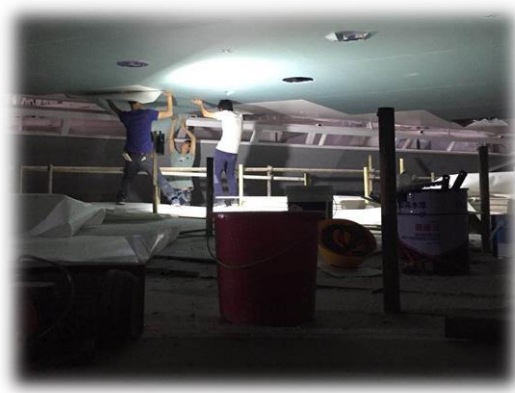
图 15 百周年纪念讲堂多功能装修改造工程室内装修施工
