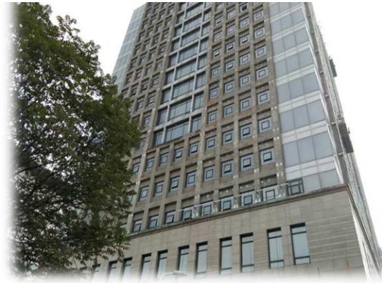
图 13 太平洋大厦外立面改造工程外立面拆除施工
