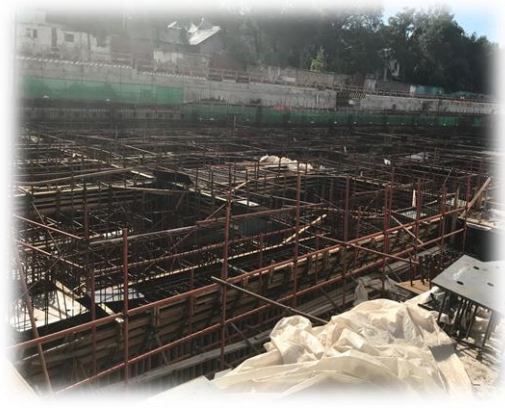
图8 景观设计学大楼II段基础垫层施工
