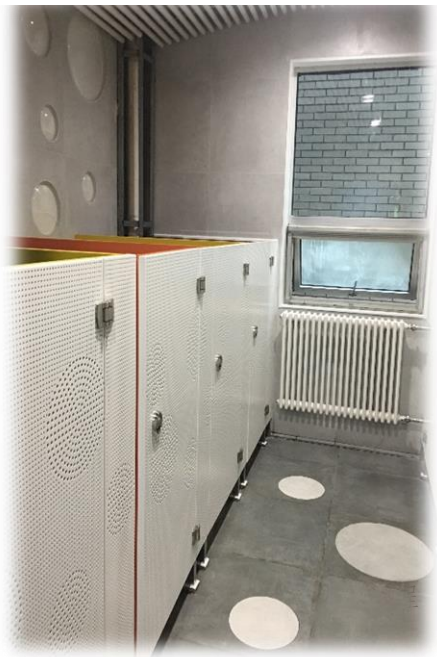
图 5 附小卫生间改造工程
