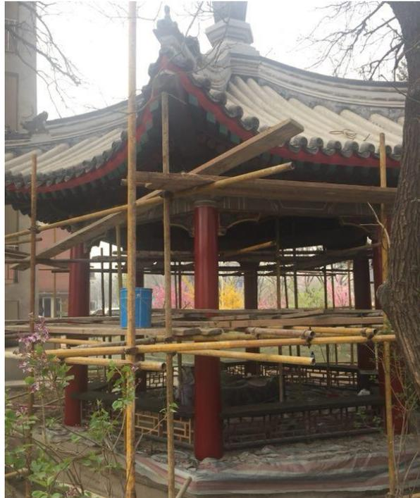
图9 校景亭长廊等古建维修工程油漆彩画施工中
