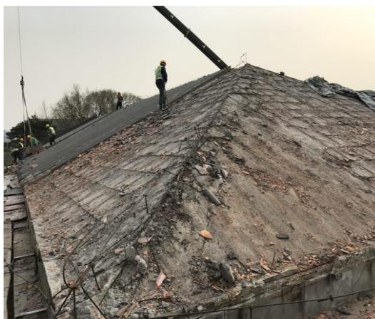
图 6 校史馆装修改造工程屋面瓦拆除完成
