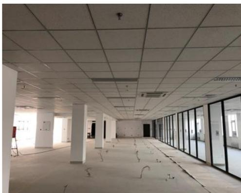
图 10 生命科学科研大楼矿棉板吊顶施工
