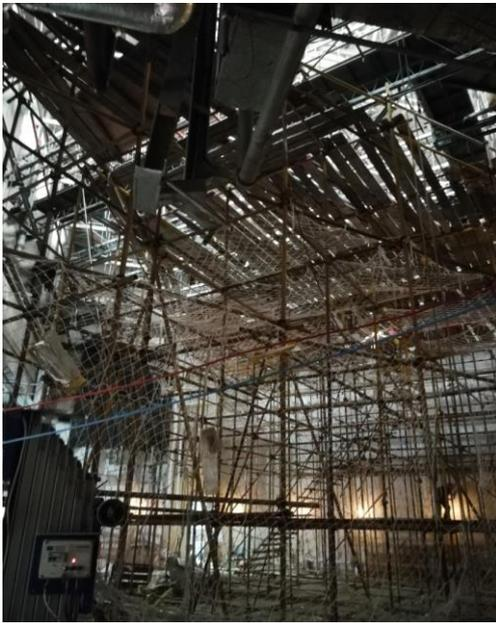
图 15 百周年纪念讲堂多功能厅装修改造钢架安装施工
