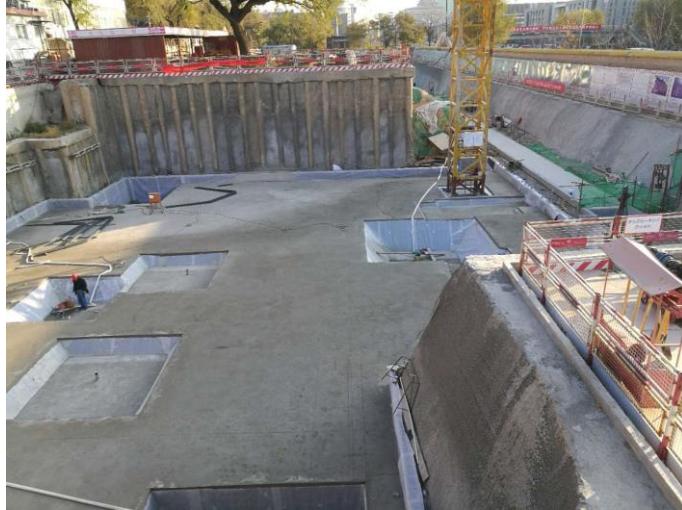
图 5 景观设计学大楼 II 段土方开挖
