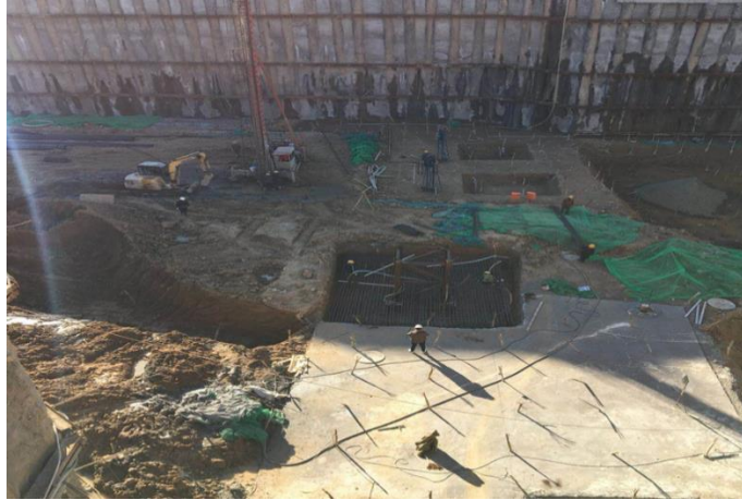
图7 国家发展研究院大楼地基处理
