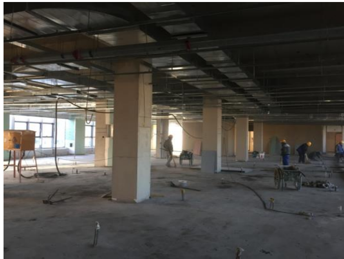
图4 生命科学科研大楼四层地面清理准备混凝土浇筑施工
