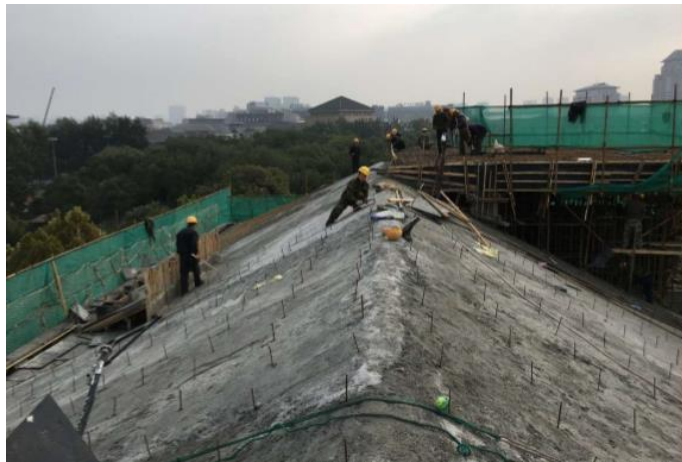
图 6 实验设备 2 号楼 II 段五层坡屋面施工
