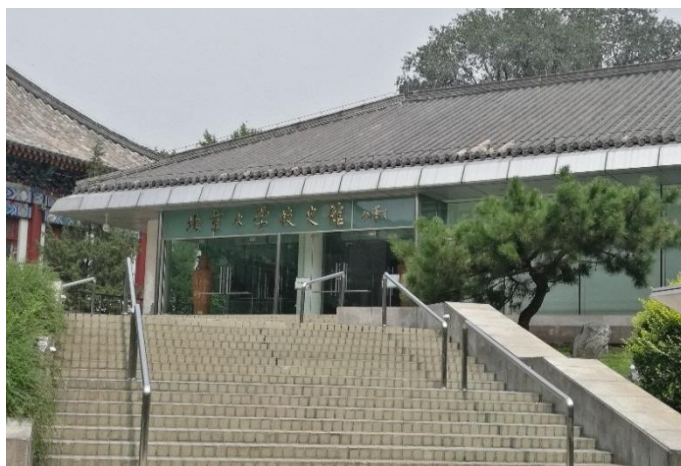
图 16 校史馆装修改造施工
