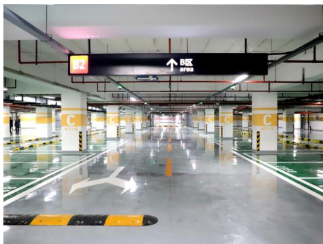
图1 地下车库（政管、法学院、二教、理科5号楼）改造工程
