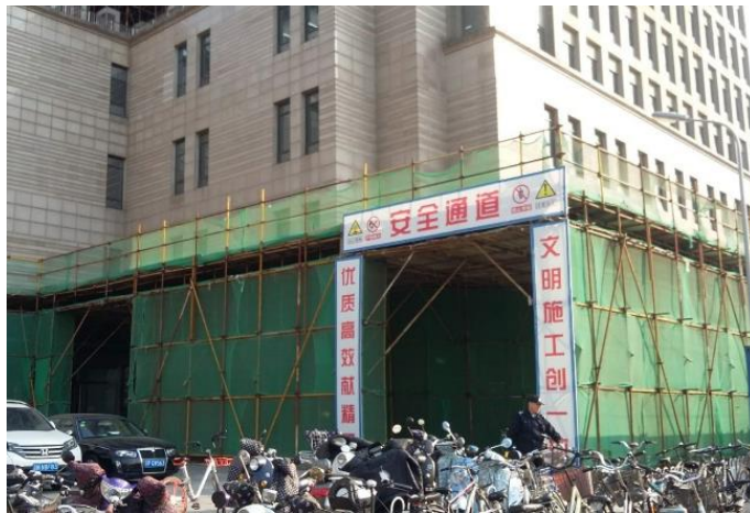
图 13 太平洋大厦外立面改造现场
