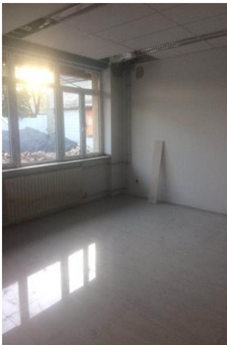
图10 继续教育学院达园宾馆一段样板间施工
