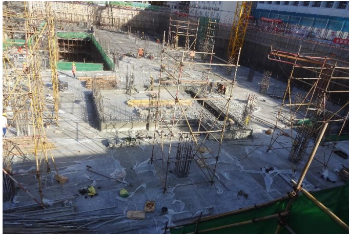
图8 餐饮综合楼工程二区、三区地下二层主体结构施工
