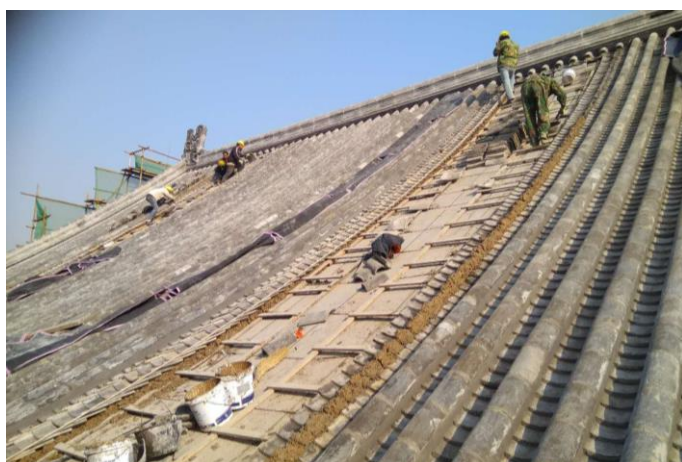
图11 俄文楼屋面施工
