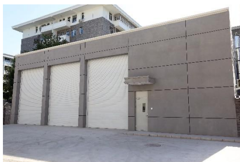
图 2 密闭式清洁站工程
