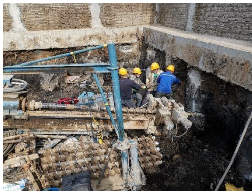
图 8 化学学院 E 区大楼土方开挖作业
