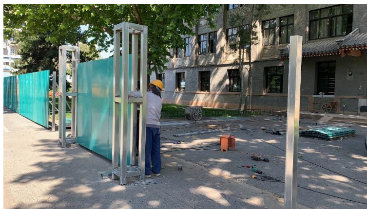
图 15 文史楼改造工程搭设临建
