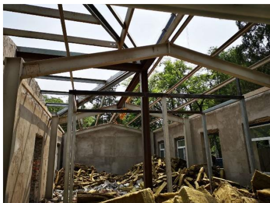
图 13 昌平校区航空航天推进实验室装修工程拆除作业
