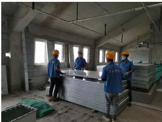
图 4 实验设备 2 号楼五层洁净实验室墙板运输
