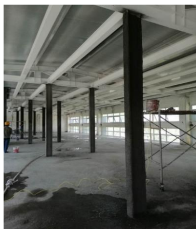
图 11 昌平园区实验动物临建设施钢结构防火涂料修补
