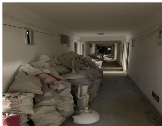
图 14 畅春园 60 号楼装修拆除建筑垃圾统一装袋、码放
