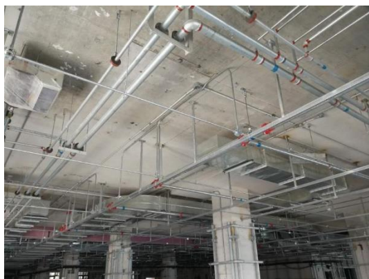
图 9 图书馆东楼修缮改造室内机电管线安装施工
