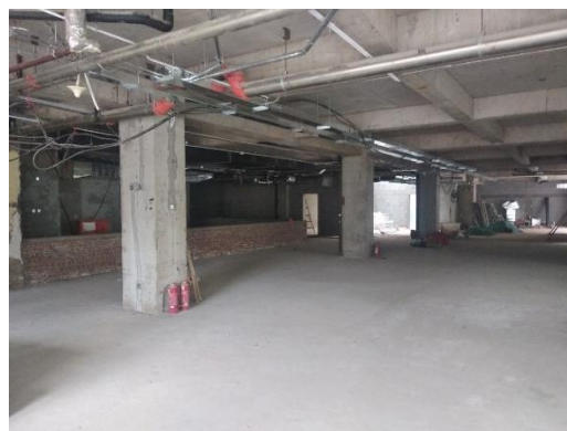
图 10 成府园食堂装修工程首层就餐区
