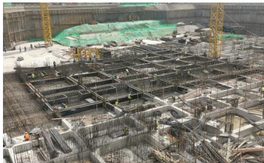
图 7 工学院与交叉学科大楼 2 号楼筏板基础施工
