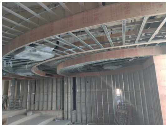
图 5 国家发展研究院顶墙龙骨安装
