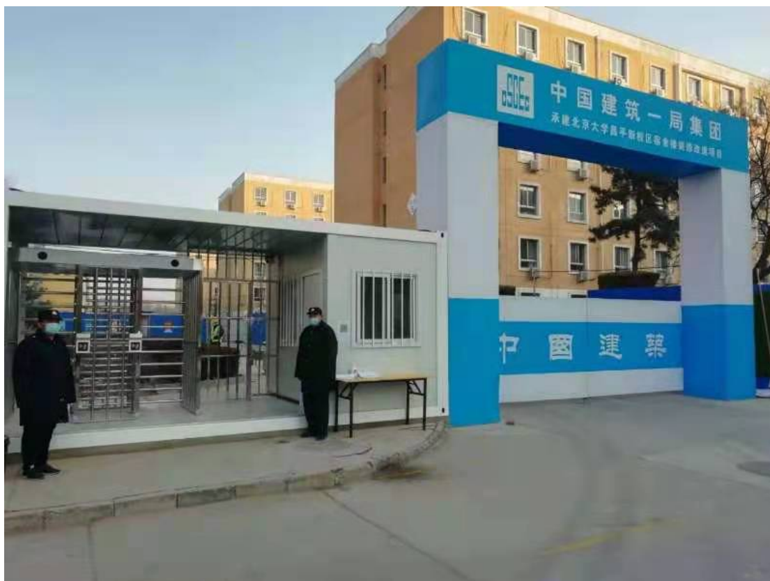
图2 昌平新校区改造工程施工现场围挡搭设
