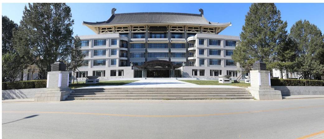
图 3 图书馆东楼修缮
