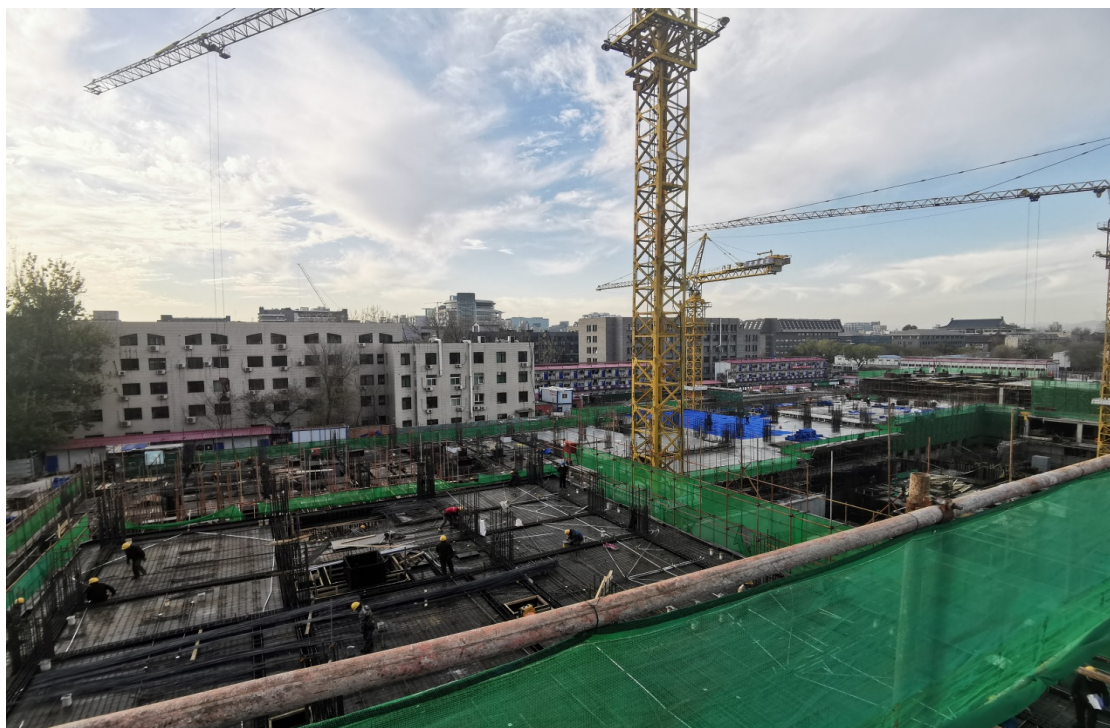
图 3 工学院与交叉学科大楼 2 号楼主体结构施工
