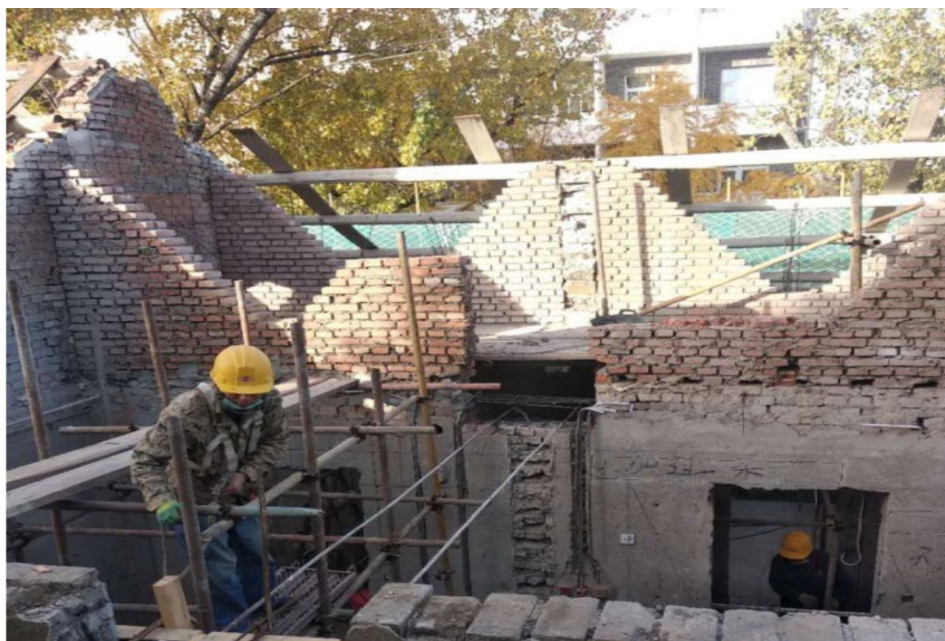
图 1 南门 20 楼三层增设钢筋混凝土梁及梁托
