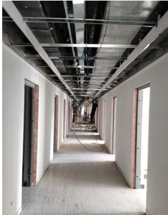
图 1 城环景观设计学大楼室内精装修
