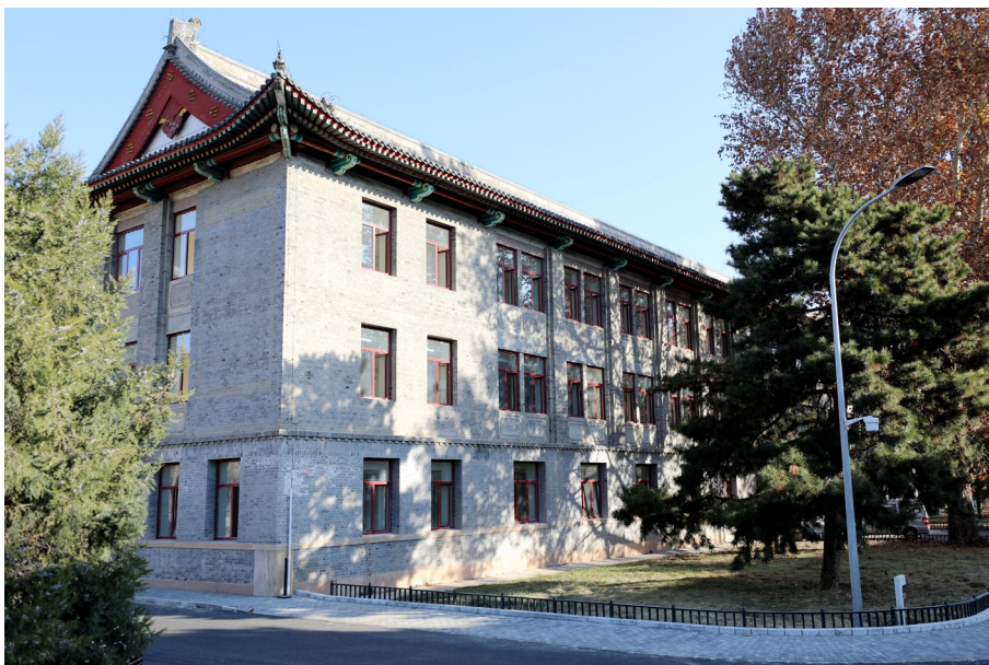
图 13 文史楼改造工程
