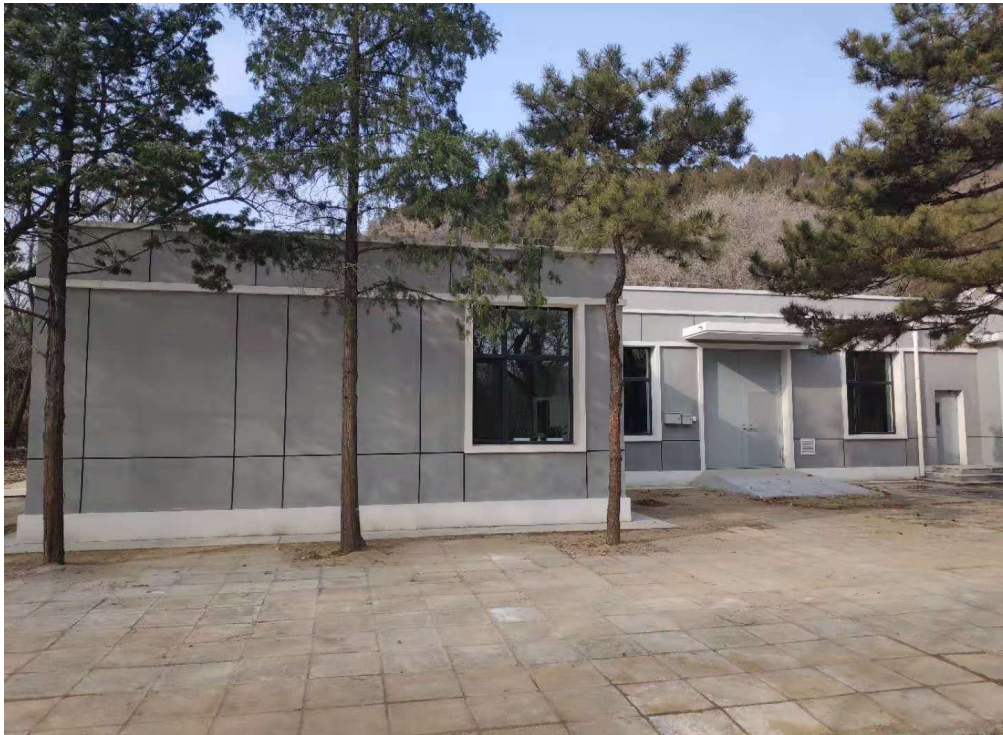
图6 昌平校区航空航天推进实验室装修
